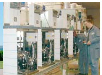
Die modernen IONOX Produktionsanlagen.
